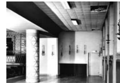
Südliches Seitenschiff. Erdgeschoss, Blick Richtung Osten, Wiederaufbau Stand 1950–1988
