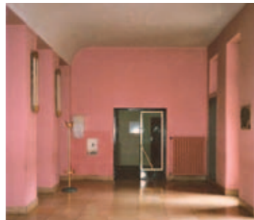
Vorhalle. Blick Richtung Südost, Wiederaufbau, Stand 1950–1988
